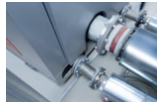
Подвод/отвод горячей воды и отвод выхлопного газа
